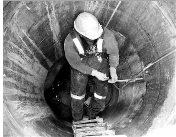
Inyección en junta de pozo de inspección.
